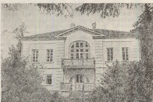
Casa în care a funcționat școala lui Tolstoi
