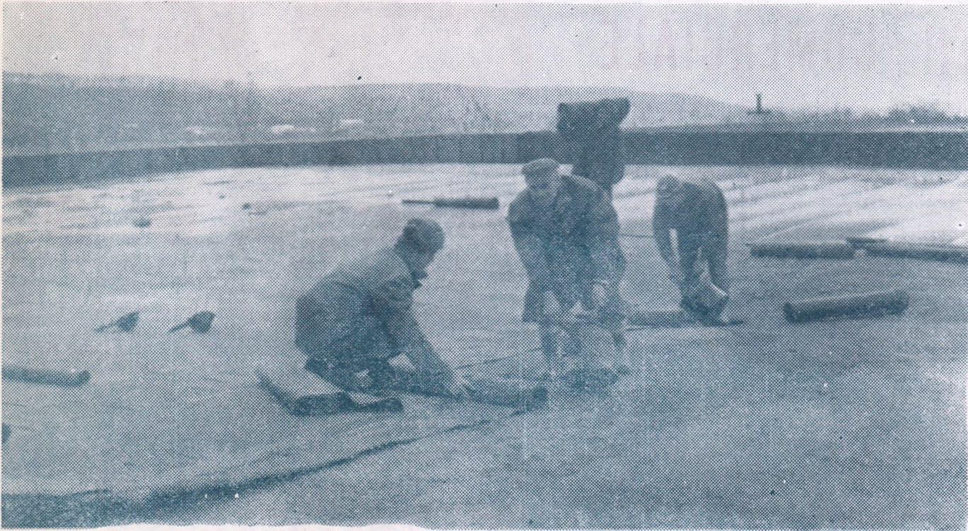
Lucrări la Filatura de bumbac - Vaslui
