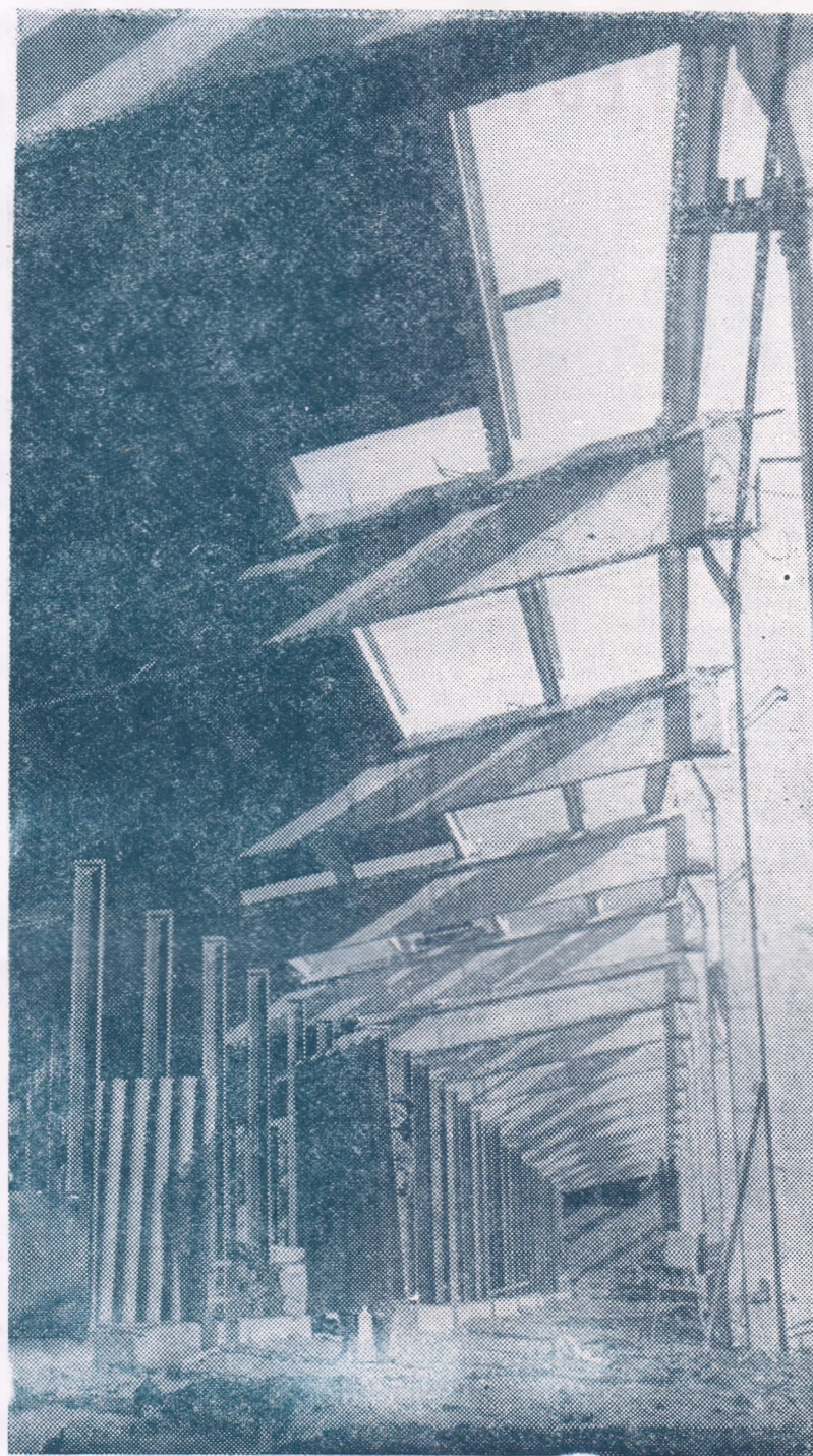
Lucrări la secția dialit
