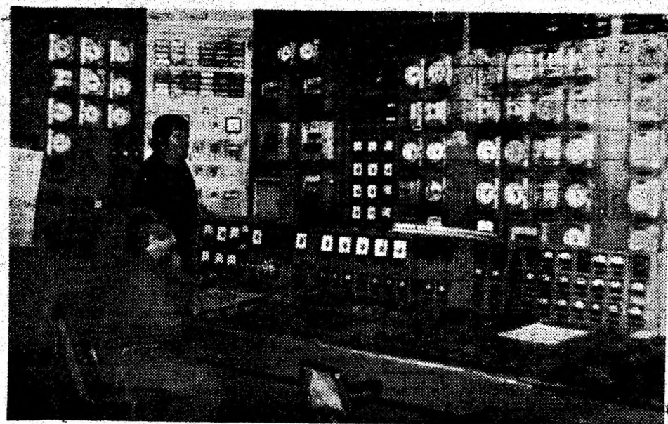
La camera de comandă a blocurilor energetice se urmărește îndeaproape încadrarea funcționării grupurilor la parametrii stabiliți.
