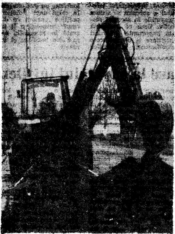
În Băcia, pentru pozarea conductelor de gaz metan a fost adusă în sprijin mecanizarea.
