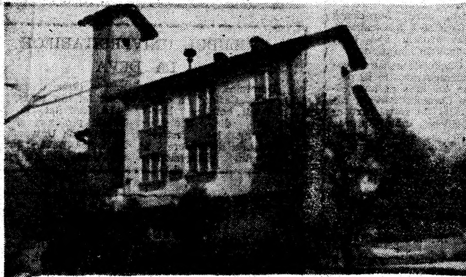
Cirjiți. Noul, modernul sediu al Consiliului local și al Poliției. Foto: PAVEL LAZA
