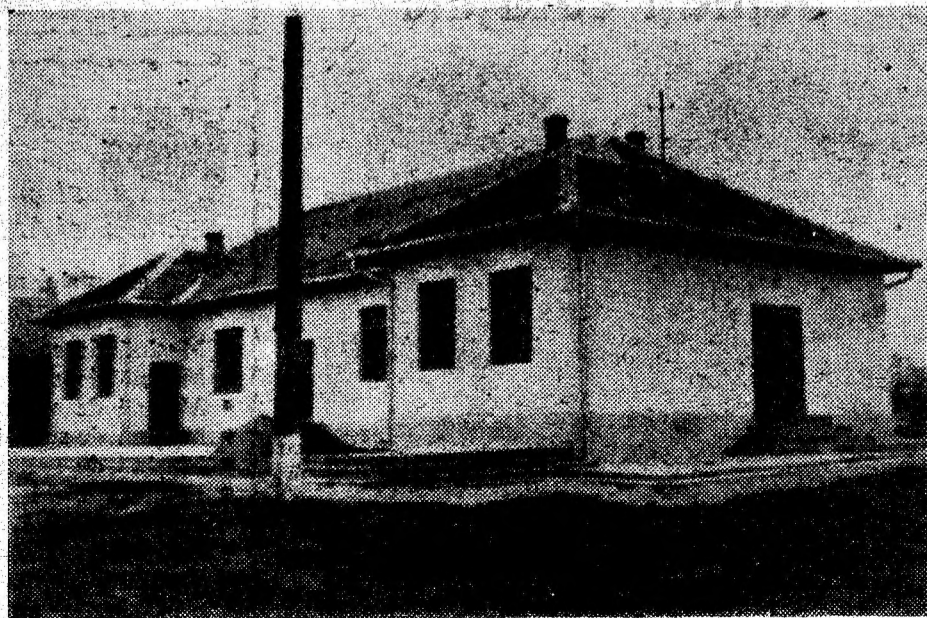
Căminul Cultural din satul Mintia, comuna Vețel, recent renovat. Foto: PAVEL LAZA
