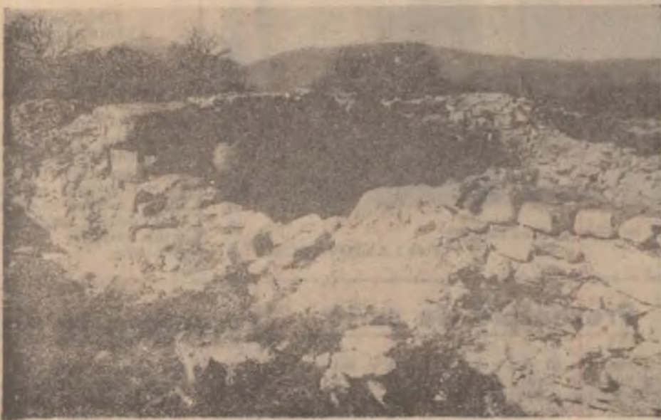
FORUL LUI TRAIAN (interior). Zi duri neamenajate care se află într-o stadiu avansat de degradare. Vântul și ploaia își spun cuvântul.
