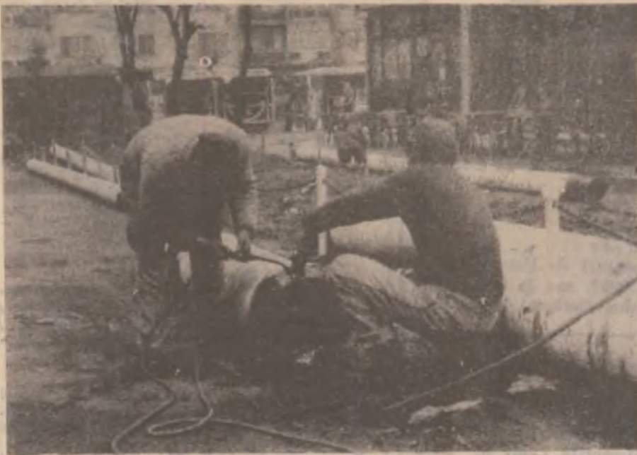
Din toată sărăcia se mai găsesc bani și pentru lucrări tehnico — edilitare. Deva, se lucrează la schimbarea conductelor de gaz în cartierul Gojdu. Foto: ANTON SOCACI
