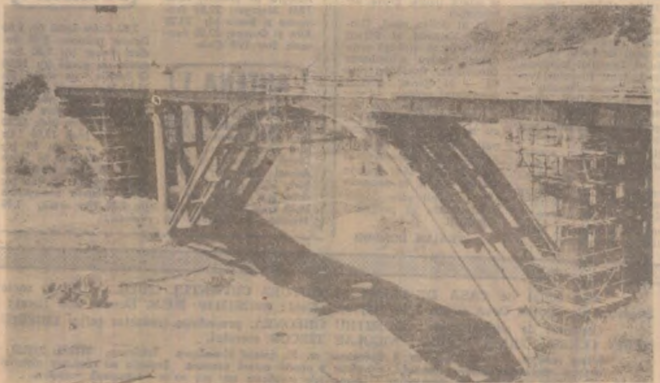
Se lucrează la consolidarea viaductului de la Ciopeia, pe D.N. 66.
