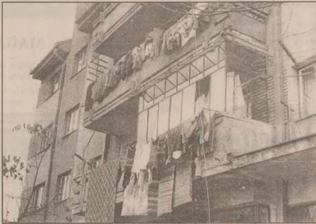
Peste drum de primăria din Certeju de Sus se află acest bloc cu balcoane transformate în uscătorii.
