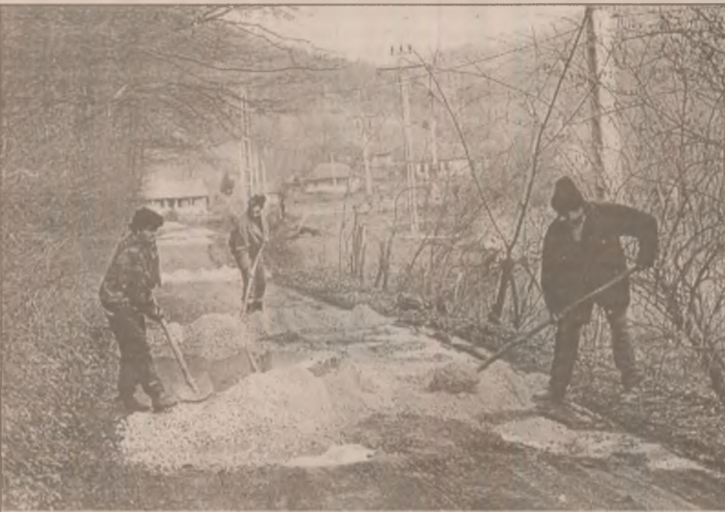
Se lucrează intens la repararea drumului dintre localitățile Boz și Căbești.
