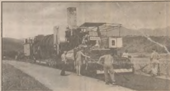
Se lucrează la repararea drumului județean BÎRSĂU - CERTEJ.
