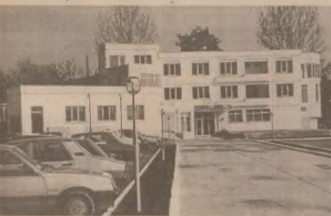
Noul complex hotelier de la Baza de Agrement Aquae Călan Foto: Traian MANU
