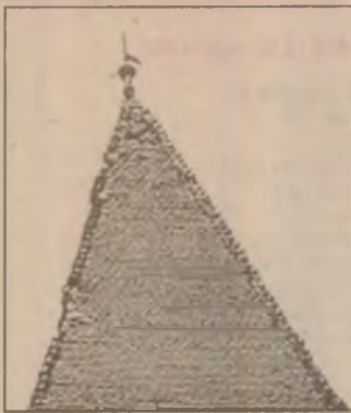
La scurt timp după terminarea lucrărilor de reparații efectuate de firma devenă Metal Express, Turnul Nou de poartă al Castelului „Corvineștilor” a arătat ca în imaginea alăturată.
