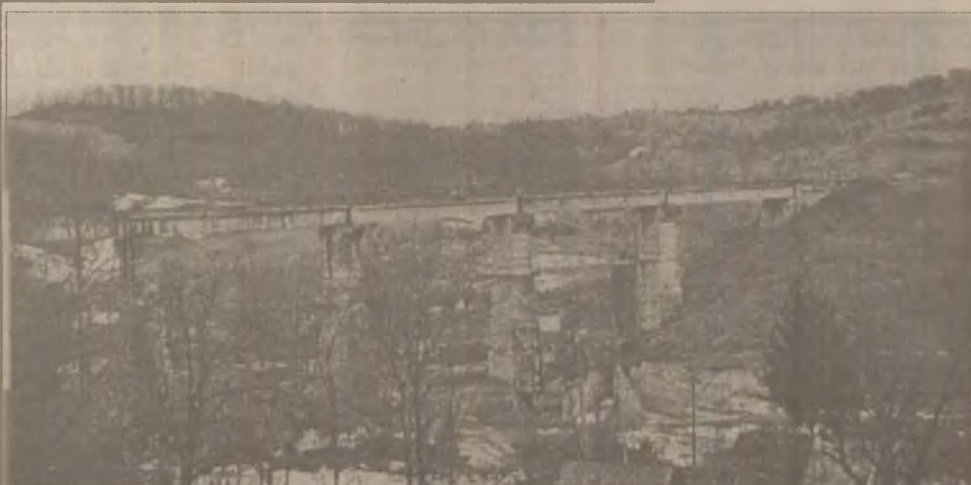
VĂLIȘOARA. Viaductul de cale ferată care făcea legătura între Deva și Brad
