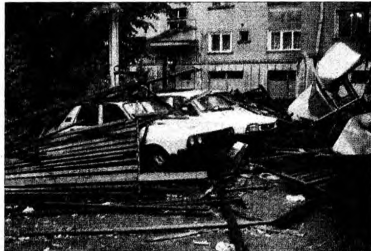
Acoperișul unui bloc s-a prăbușit peste mașinile din parcare.
