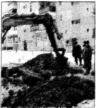
Au început reparațiile!
