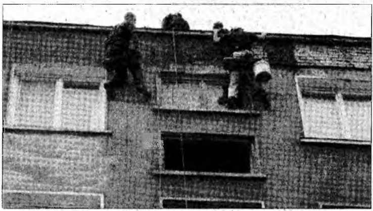
La lucru pe acoperișul blocului
