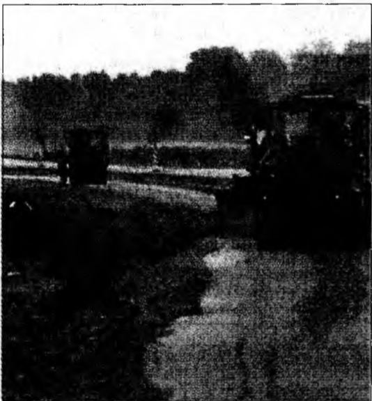
Se repară drumul Adjud-Focșani
