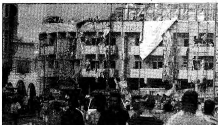
Hotelul Al-Sadir, din centrul capitalei Irakului, distrus în urma exploziei mașinii-capcană (Foto: EPA)
