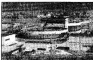
Stație de tratare a apei
