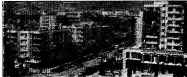
Deva va avea străzi modernizate (Foto: T. Manu)
