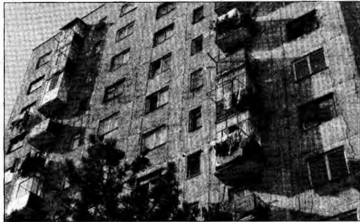
Zidurile de rezistență ale blocurilor nu pot fi dărâmate (Foto: CL)
