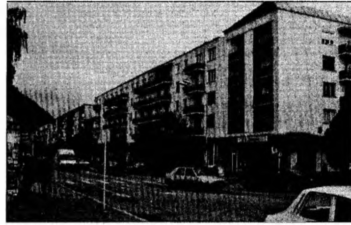
Majoritatea blocurilor din Deva trebuie reabilite termic. (Foto: ...)
