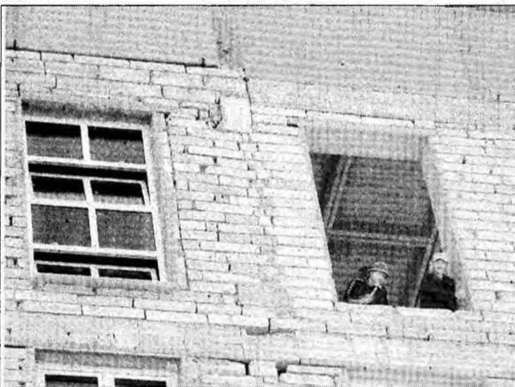
Muncitorii trag din greu pe șantier
