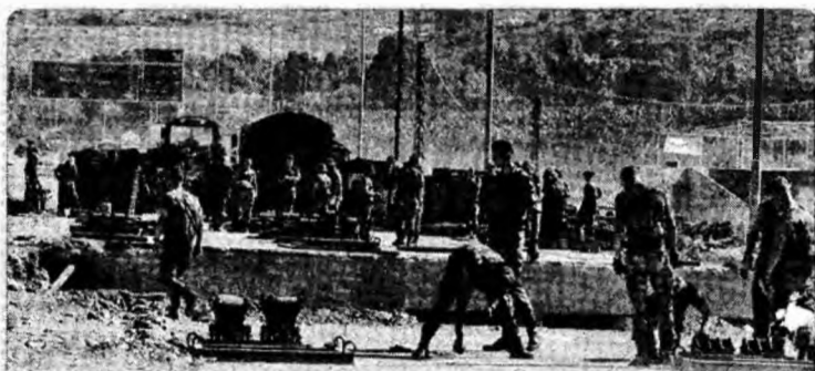
Reconstrucție Trupele franceze din cadrul FINUL construiesc un pod în sudul Libanului, în cadrul misiunii de reconstrucție a țării distruse de bombardamentele israeliene. (Foto: EPA)
