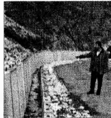
Drumurile au șanțuri colectoare
