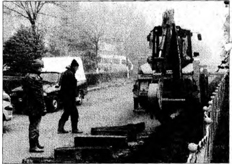
Scuarul dintre cele două benzi ale bulevardului Iuliu Maniu va fi îngustat (Foto: T. Manu)
