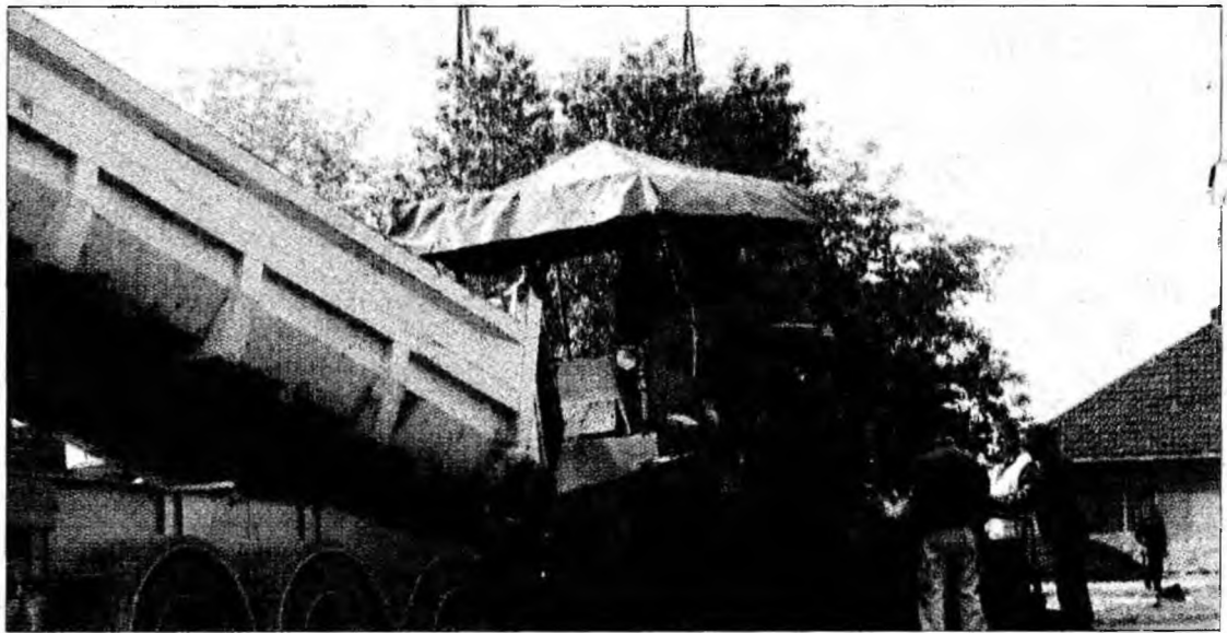
S-au alocat bani pentru repararea drumurilor
