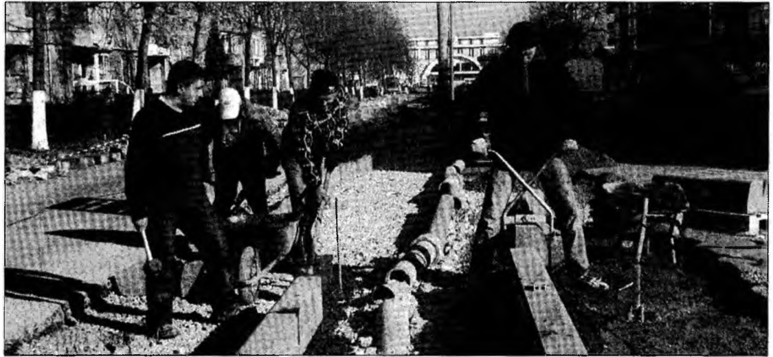
Lucrări la drumurile principale finanțate de la bugetul Primăriei Deva
