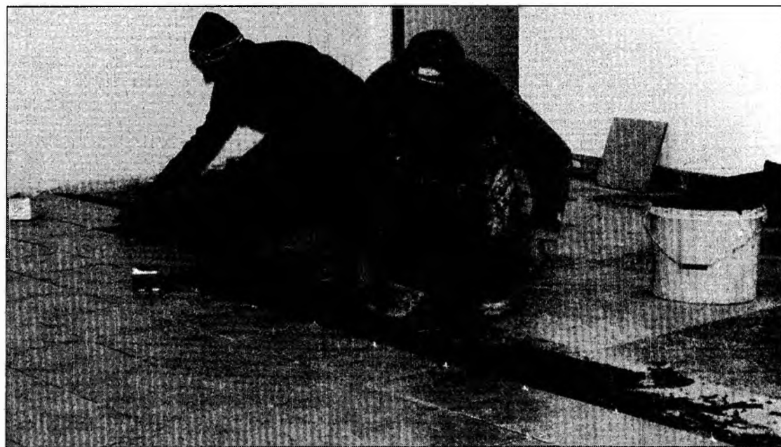
Montarea unui metru pătrat de gresie costă minimum 15 lei
