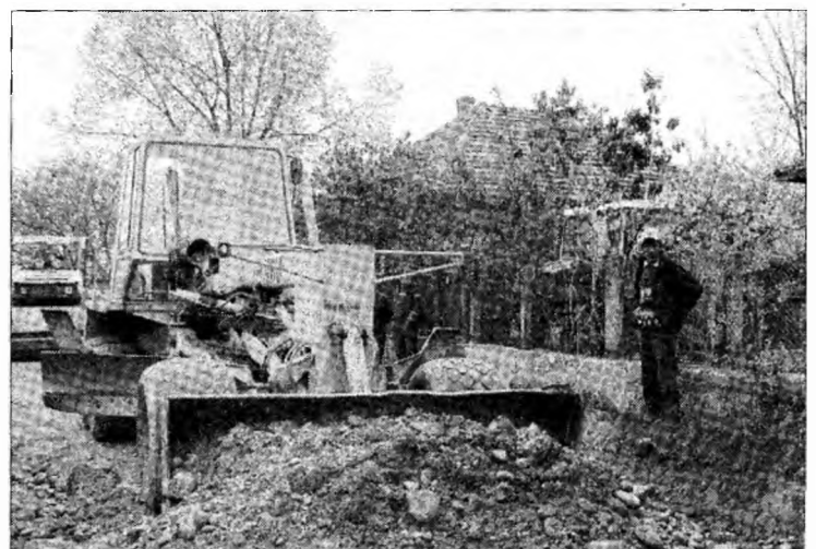
Utilajele pregătesc infrastructura drumului
