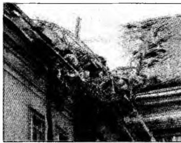
La Viena, o macara prăbușită (Foto: EPA)
