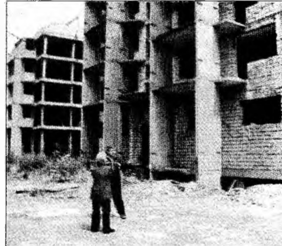
Și celelalte blocuri părăsite își așteaptă rândul
