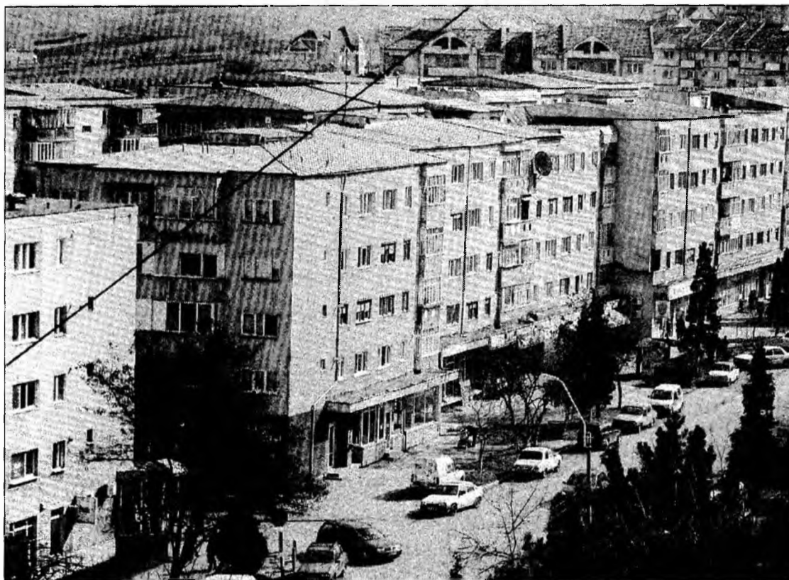
Cele mai multe din apartamentele devene au nevoie de reabilitare termică
