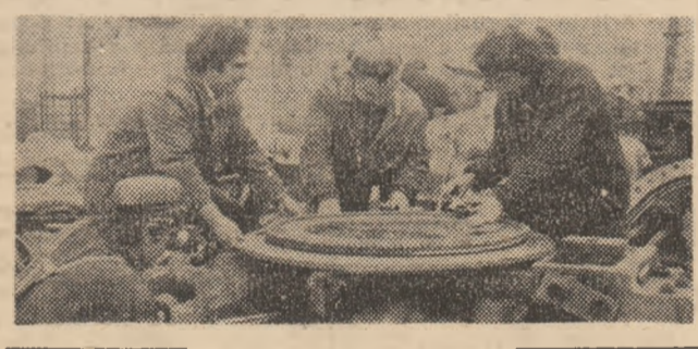
Șantierul Riu Mare-Retezat — Atelierele centrale Hațeg. Echipa de reparații utilaj minier condusă de maestrul Dionisie Socaci execută reparații la o mașină de excavat și încărcat P.P.M-3.
