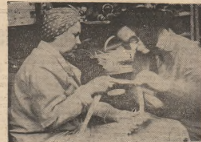
C.S.H. Atelierul de reparații electrice. Muncitoarele Susana Mozeș și Cristina Mangan execută lucrări de recondiționare a conductorului de cupru alit de necesar economiei naționale.
