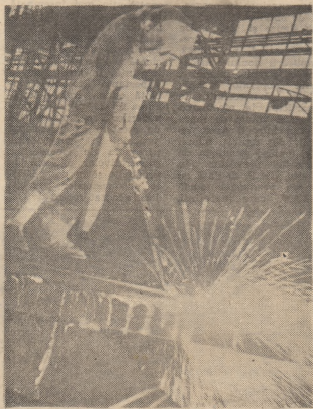
C.S. Hunedoara - laminorul de semifabricate II. Aspect de la flamarea laminatelor.
