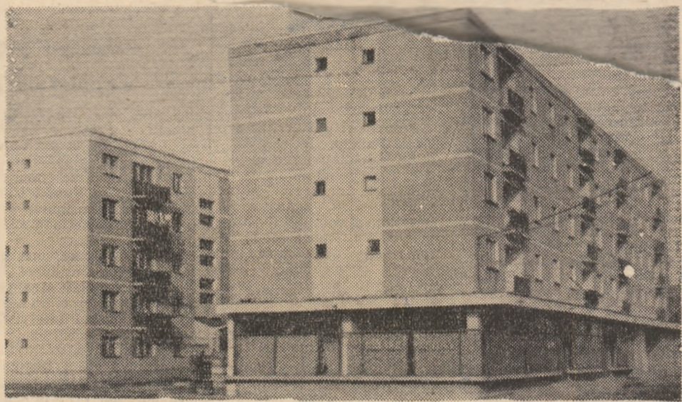
Blocuri pentru mineții din Cereș.
