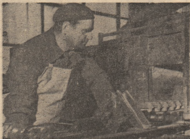
I.M.C. Bircea, atelierul teracota. Muncitorul Lazăr Neamțu introduce cahele de teracotă în tunelul de ardere.
