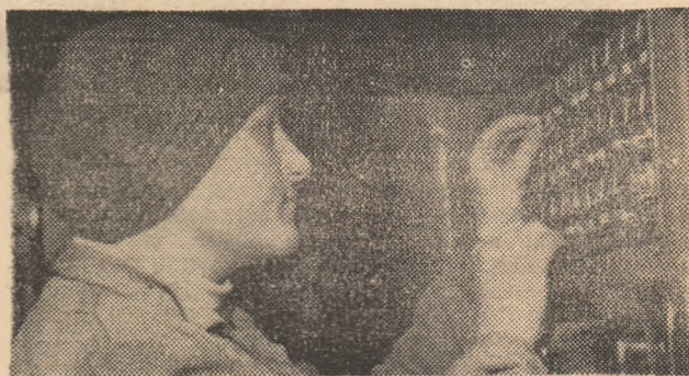
Depoul C.F.R. Simeria. Electricianul Elena Vesa, de la sectorul de reparații L.E.1, este un bun meseriaș, execută reparații de bună calitate.
