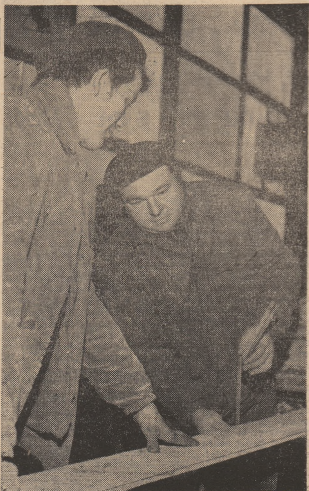
I.M.M.E. Simeria, secția a II-a vagoane marfă. Timpării Gheorghe Stana și Aurel Avram execută degroșarea materialului lemnos necesar la repararea vagoanelor.
