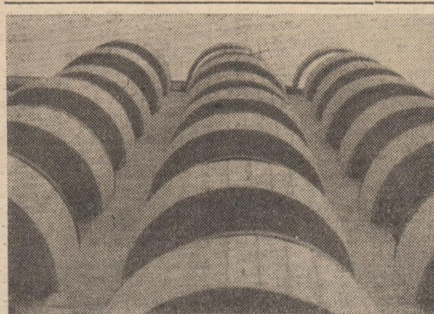
Noi armonii arhitectonice ale blocurilor din municipiul Deva. Foto: DAN CAMPEAN
