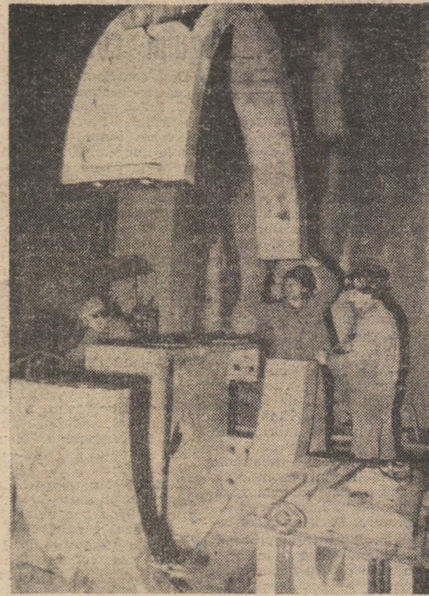
Mezaros Ștefan și Nagy Ștefan de la Centrala subterană Brazi, brigada I, pregătesc montarea compensatorului conului aspirator de la turbina II.
