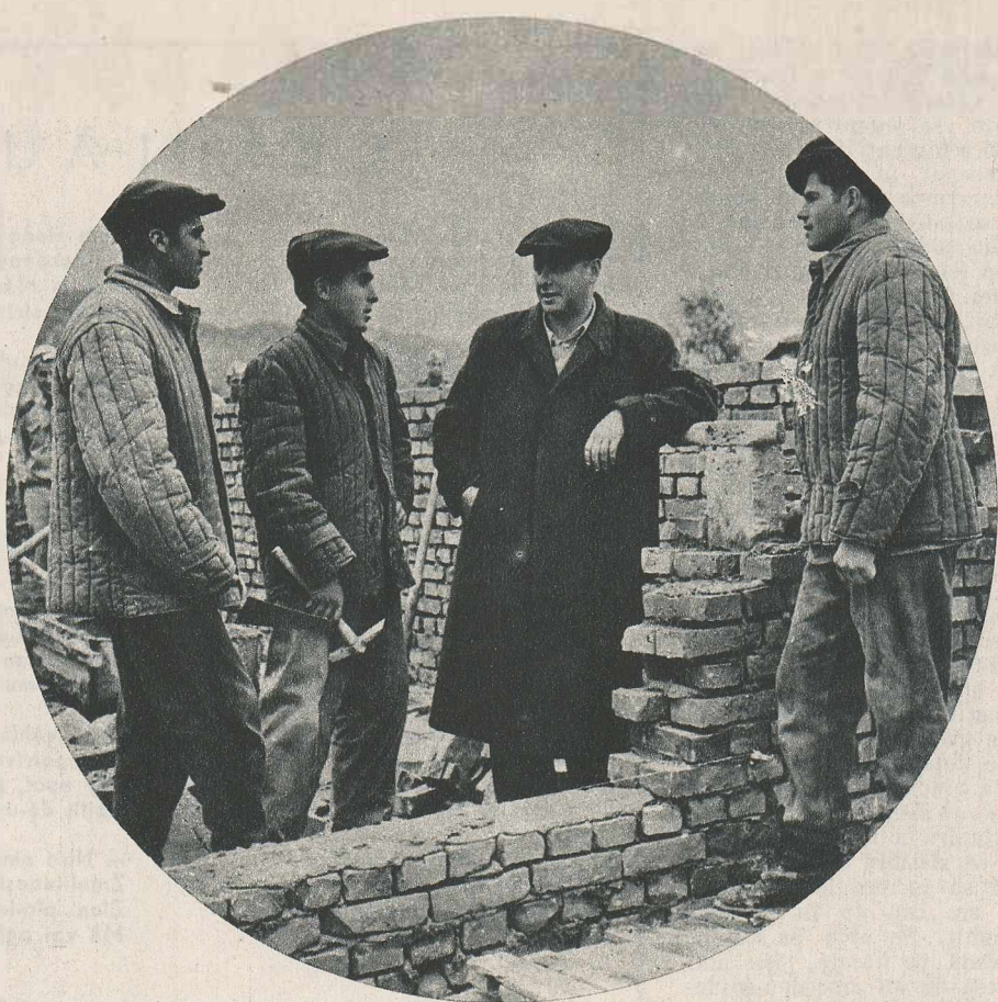
Directorul a venit pe șantier... Stînd de vorbă cu constructorii, deseori te apacă noaptea fără să-ți dai seama cum se scurge timpul...
