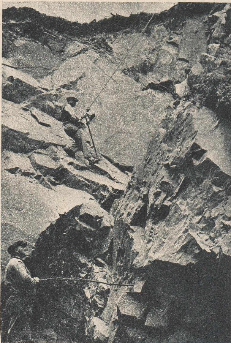
La cariera de piatră. Maistrul minier Traian Crainic privește de jos cum, agățat de o frînghie solidă, minerul Petru Sirban doboară cu ranga stîncile dislocate de puterea exploziei.
