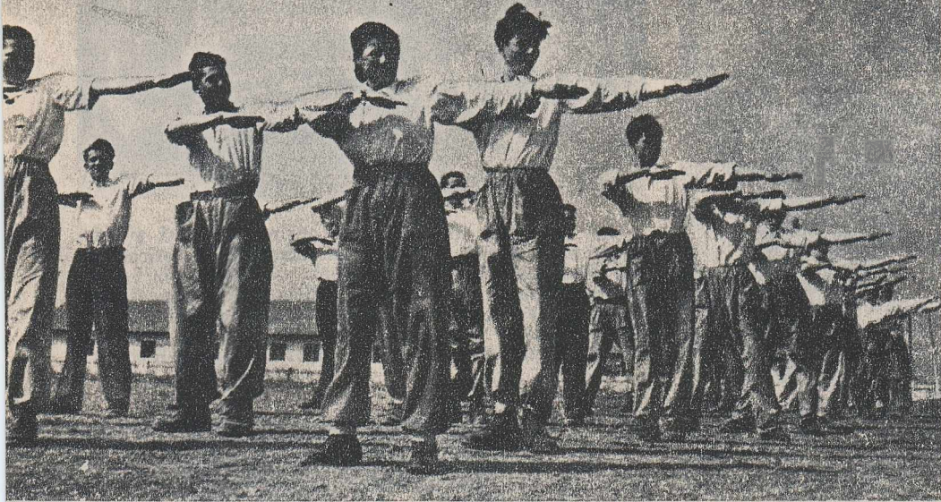
În zori, înainte de începerea lucrului, tinerii constructori ai orașului muncitoresc Hunedoara fac exerciții de înviorare.
