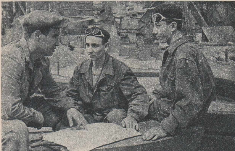
Înainte de începerea turnării, Ion Bălan dă ultimele sfaturi tovarășilor din brigada sa.
