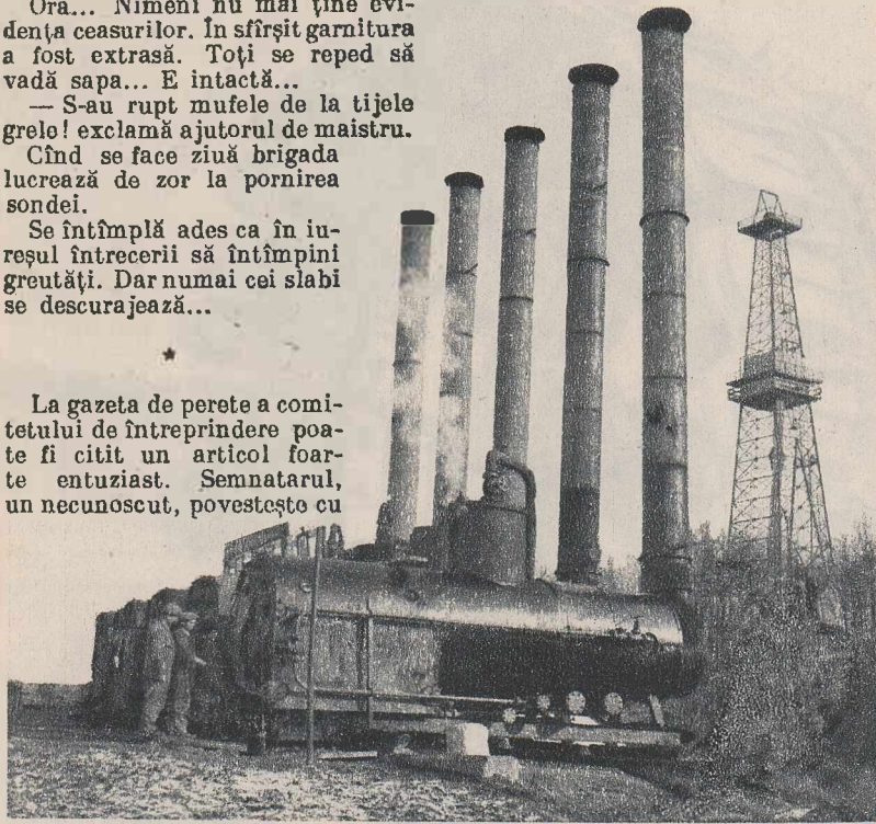
Instalațiile care asigură sondelor energia necesară forajului merg din plin; doar și mecanicii de la cazanele de aburi sînt în întrecere! În privința asta sondorii nu au nici o grijă: vor avea abur suficient.
