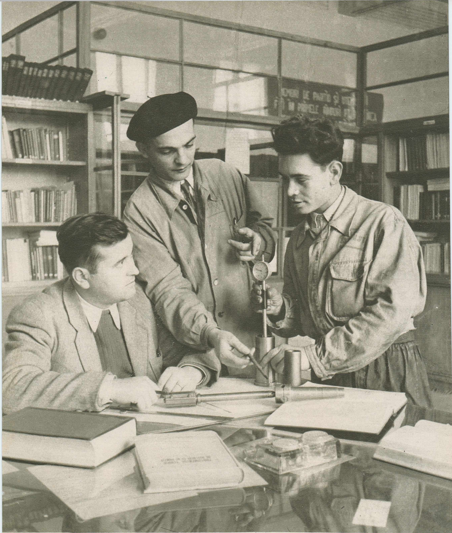
cabinetul tehnic al uzinelor „23 August” a venit unul dintre inovatorii tineri. In fata inginerului Gheorghe Ichim și a tehnicianului Tudor Manea, mistul strungar Marcu Reichman prezintă prima lui inovație: un dispozitiv pentru alizarea ghidurilor la tacheții motoarelor românești „23 August”.
