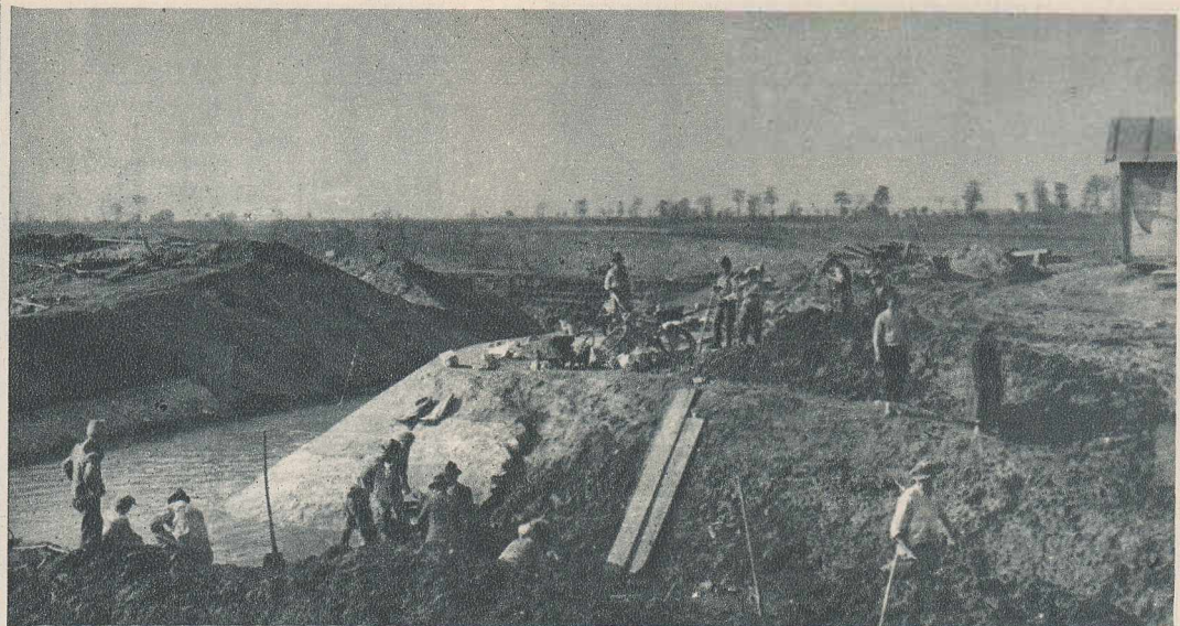
Cu câteva luni în urmă în acest loc se întindea o mlaștină cu stuțăriș. S-a lucrat mai mult cu mașinile. Draglinele au excavat peste 1600 metri cubi de pământ. Aici se va ridica stăvilorul care va dirija debitul apei.
