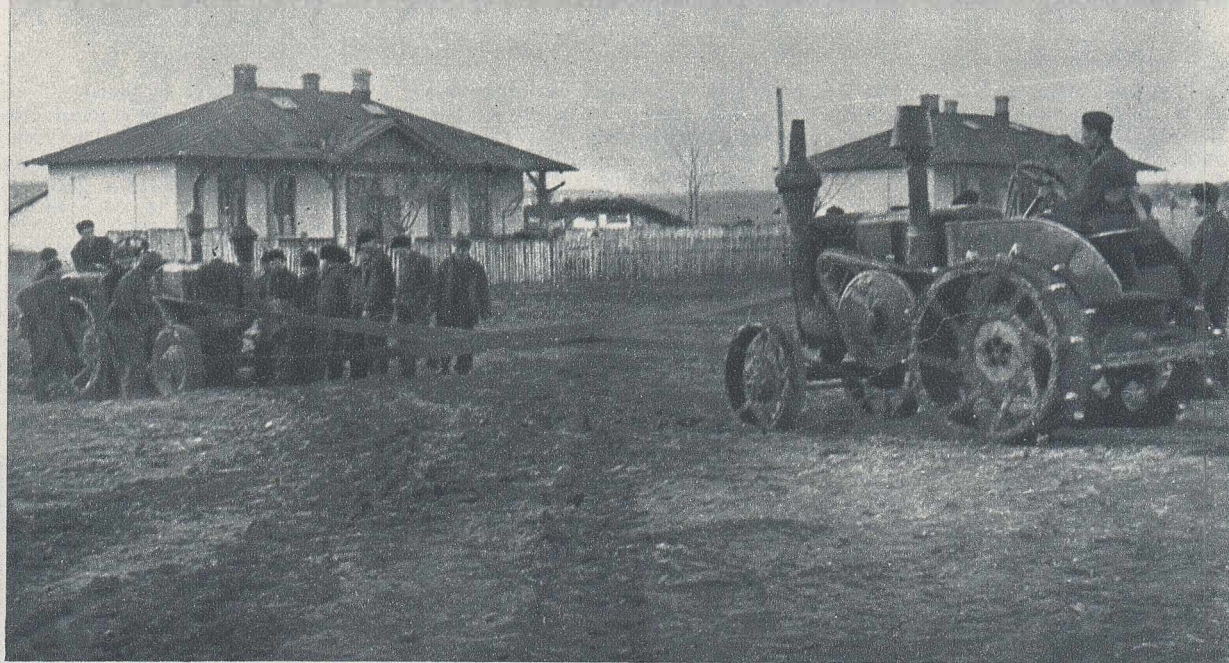
Să nu credeți că aci se face o probă de putere între tractoare. Are loc rodajul la rece.
