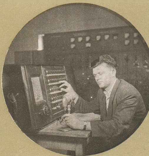
Centrala operativă. De aici, se dirijează toate comenzile de anclanșări și declanșări electrice. În fotografie, șeful de tură Viorel Topliceanu.
