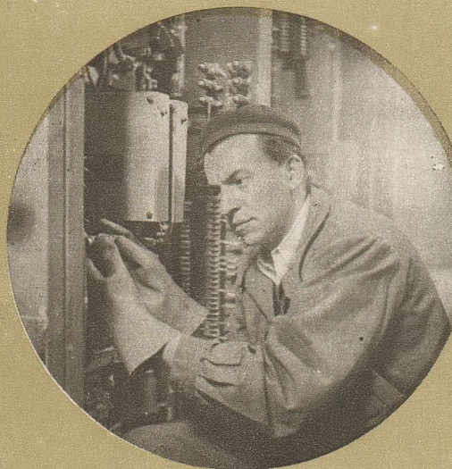
Pascu Tiberiu, șef de tură la centrala operativă, verifică conexiunile de circuit secundare.
