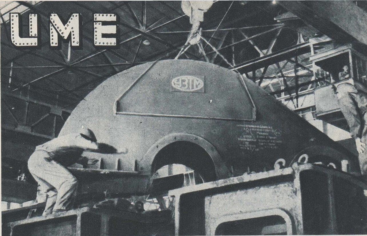
Se montează capacul unui perforator.
